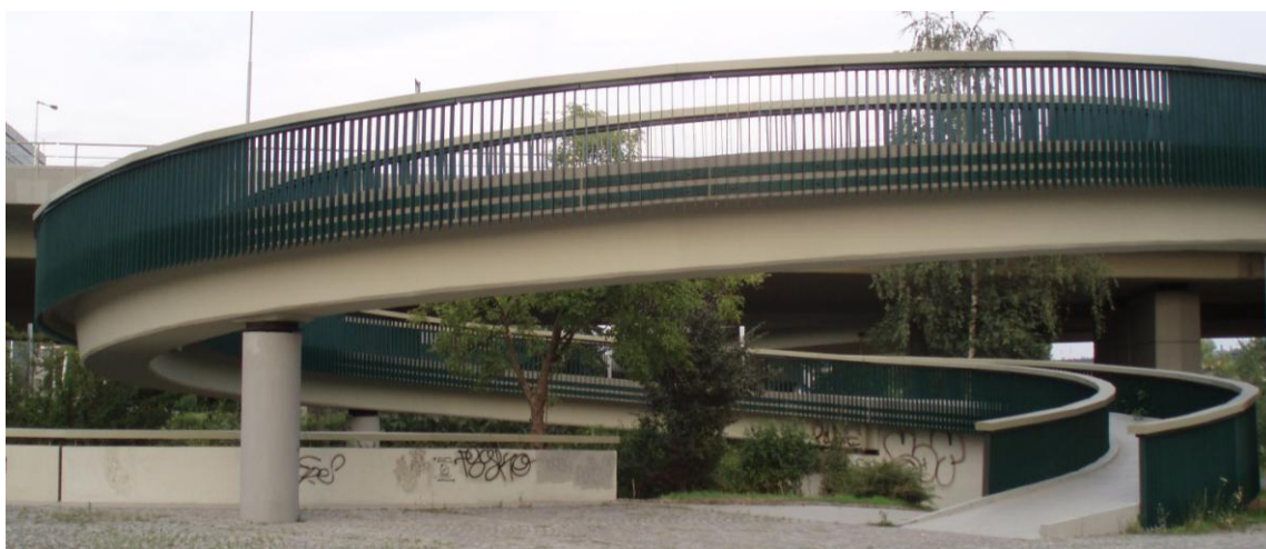
Obrázek 5.16: Použití přímé uzavřené přímkové šroubové plochy u lávky spojující komunikace ve dvou úrovních – Praha, ČR
