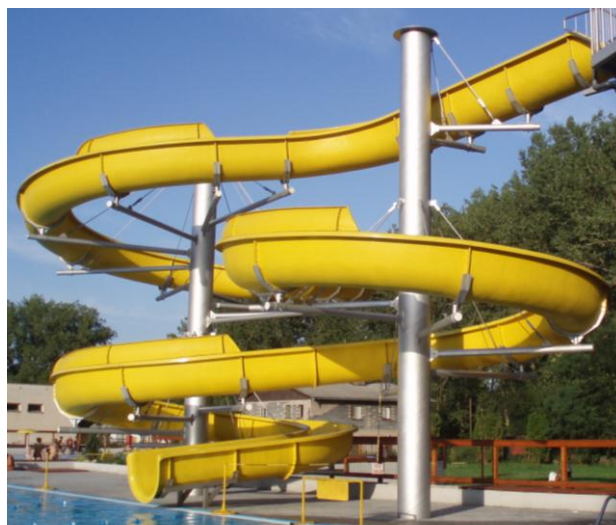
Obrázek 5.21: Části Archimédovy serpentine u tobogánu – Vlašim, ČR
