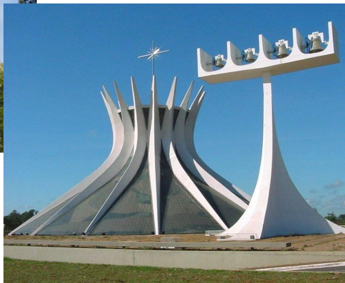
Obrázek 11: Rotační jednodílný hyperboloid - katedrála (architekt Oscar Niemeyer) – Brasília, Brazílie ( http://www.trekearth.com )
